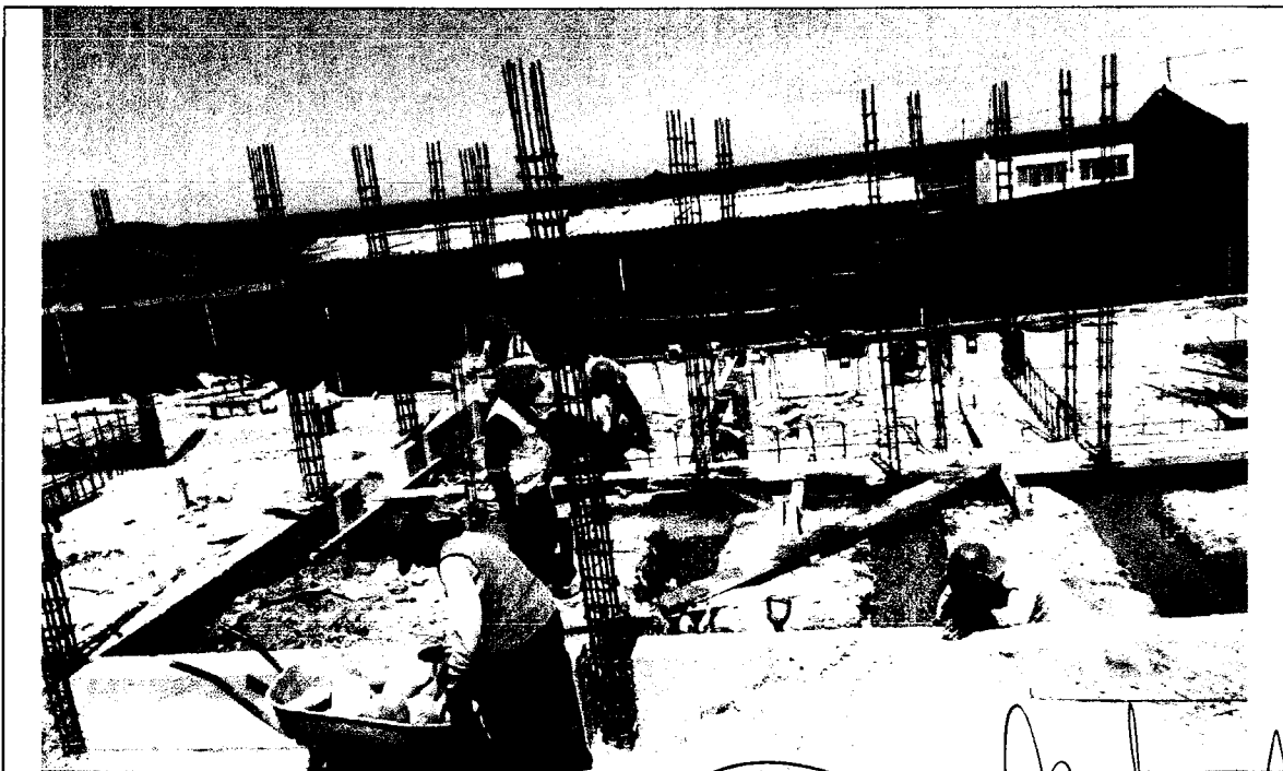
Foto N° 04: VACIADO DE CONCRETO CICLOPEO EN CIMIENTOS CORRIDOS DEL MODULO.
