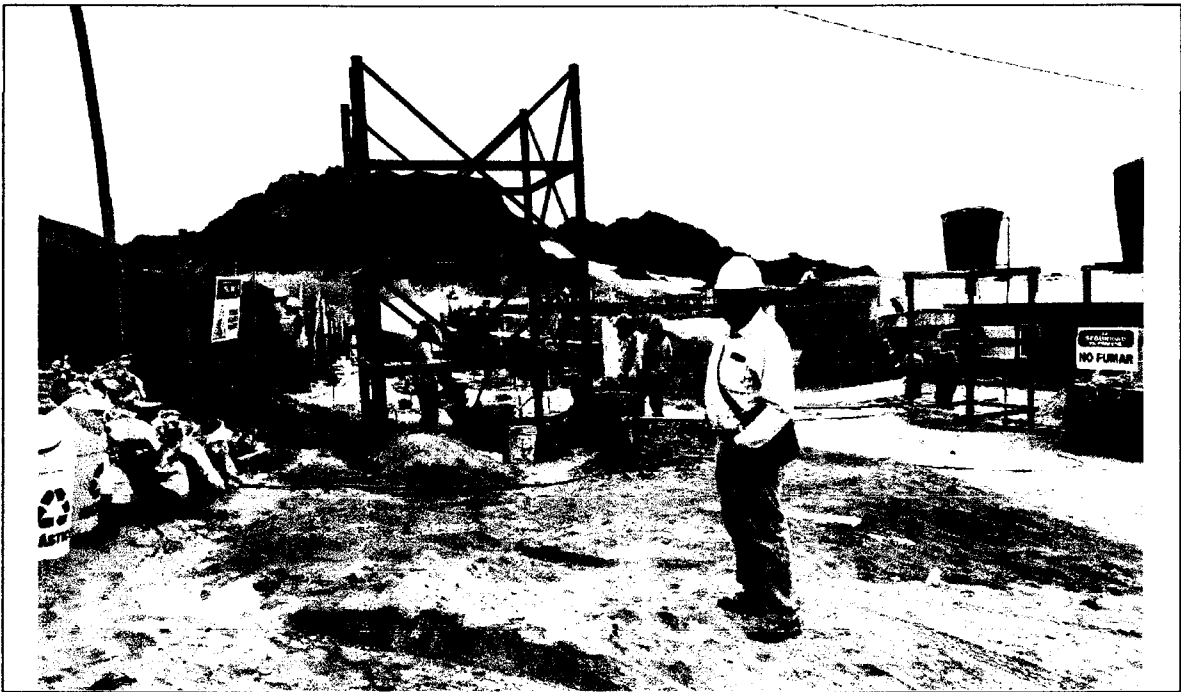
Foto N° 33: PRESENCIA DEL SUPERVISOR DE OBRA EN EL IZAJE DE LA ESTRUCTURA DE ACERO QUE SOPORTARA EL TANQUE ELEVADO.
