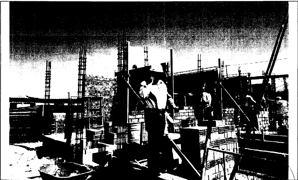
Foto N° 18: ASENTADO DE LADRILLOS PARA MUROS Y TABIQUES EN PRESENCIA DEL SUPERVISOR DE OBRA EN EL IMELEC S.R.L.
