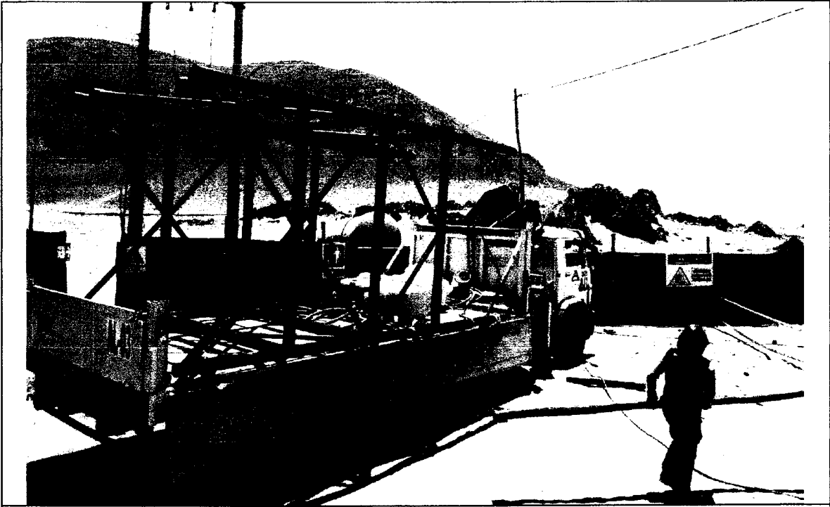
Foto N° 31: TRANSPORTE TERRESTRE DE LA ESTRUCTURA DE ACERO QUE SOPORTARA EL TANQUE ELEVADO.
