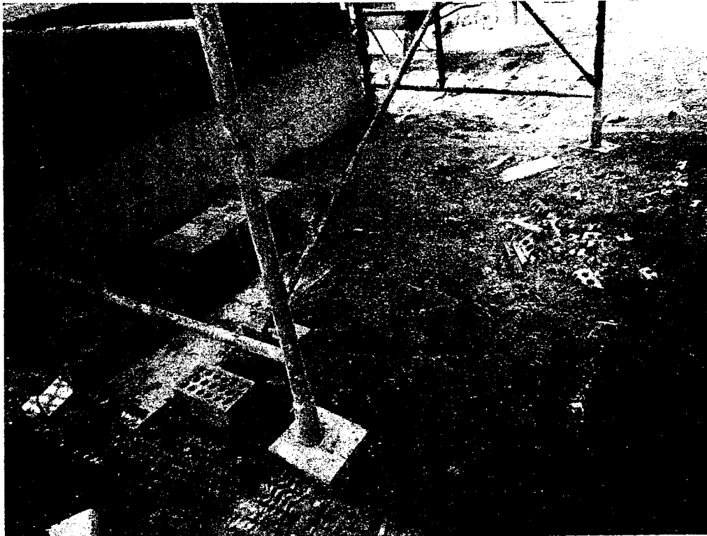
ARMADO DE ANDAMIO CUMPLIENDO LO QUE PRESCRIBE LA NORMATIVA. LA BASE DEBE DESCANSAR SOBRE MADERA, JAMAS SOBRE LADRILLOS
