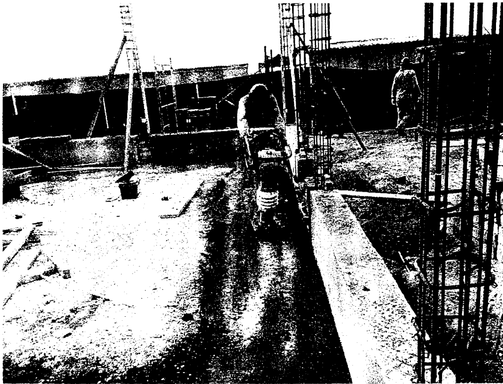
LABORES DE COMPACTADO. TRABAJADOR UTILIZA EQUIPO DE PROTECCION INDIVIDUAL ASI COMO PROTECTOR DE OIDO
