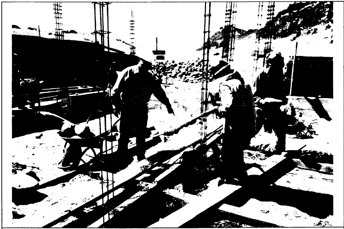
Foto N° 05: VACIADO DE CONCRETO CICLOPEO EN CIMIENTOS CORRIDOS DEL MODULO II EN PRESENCIA DEL SUPERVISOR DE OBRA.
