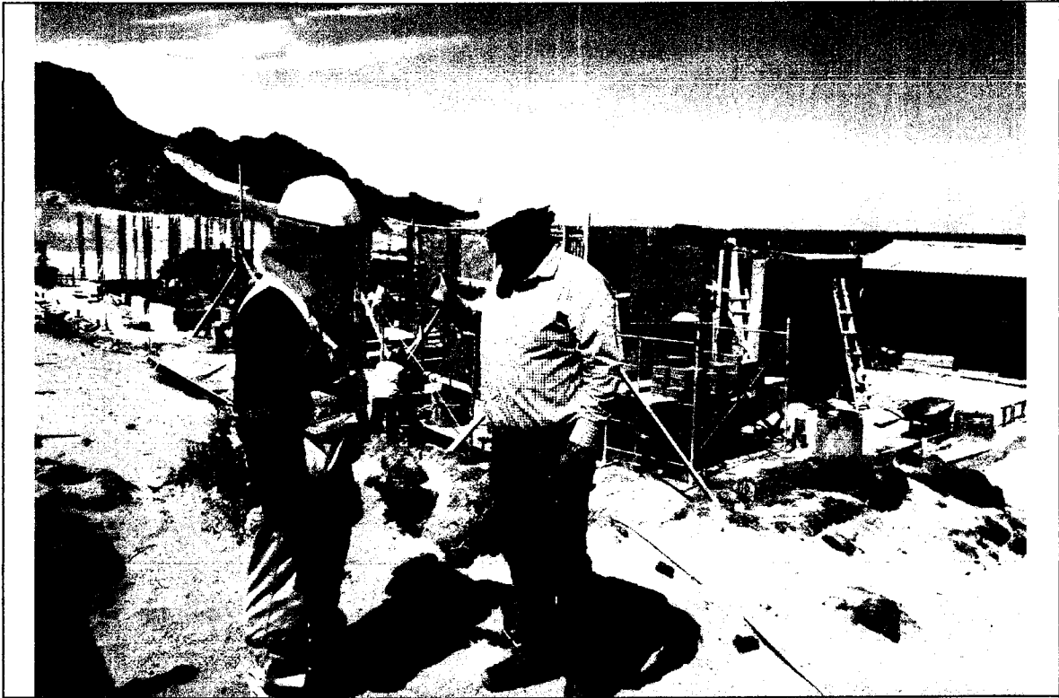
Foto N° 21: COORDINACIONES ENTRE EL RESIDENTE Y MAESTRO DE OBRA.
