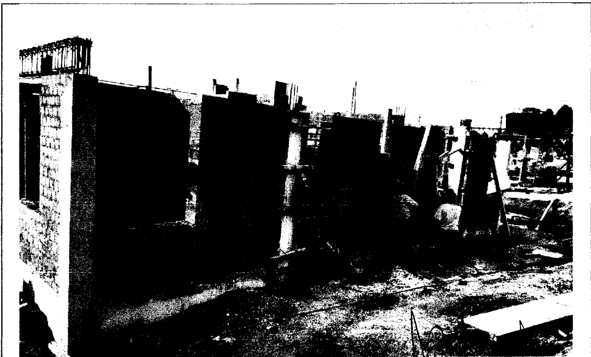
Foto N° 22: ENCOFRADO DE COLUMNAS DEL MODULO I.
