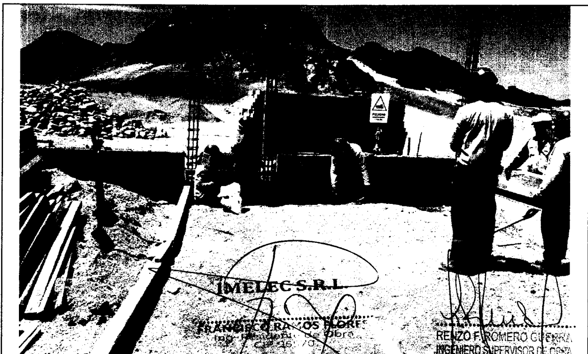
Foto N° 02: TRAZO Y REPLANTEO EN CIMIENTOS CORRIDOS, PARA PROCEDER A LA EXCAVACION.
