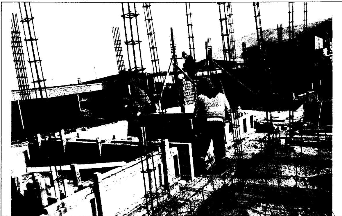
Foto N° 08: ENCOFRADO DE SOBRECIMENTOS INTERNOS DEL MODULO II.
