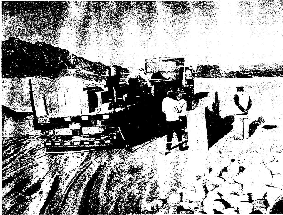
DESCARGA DE LADRILLOS EN OBRA. PERSONAL UTILIZA EQUIPOS DE PROTECCION OBLIGATORIA
