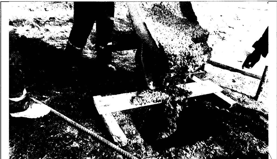
Foto N° 30: VACIADO DE CONCRETO F'C=175 KG/CM2 EN SUB ZAPATAS PARA LA ESTRUCTURA DE ACERO QUE SOPORTARA EL TANQUE ELEVADO.
