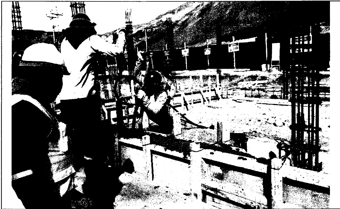
Foto N° 15: UTILIZACION DE VIBRADORA DE CONCRETO EN VACIADO DE SOBRECIMIENTO ARMADO, PARA EVITAR CANGREJERAS.
