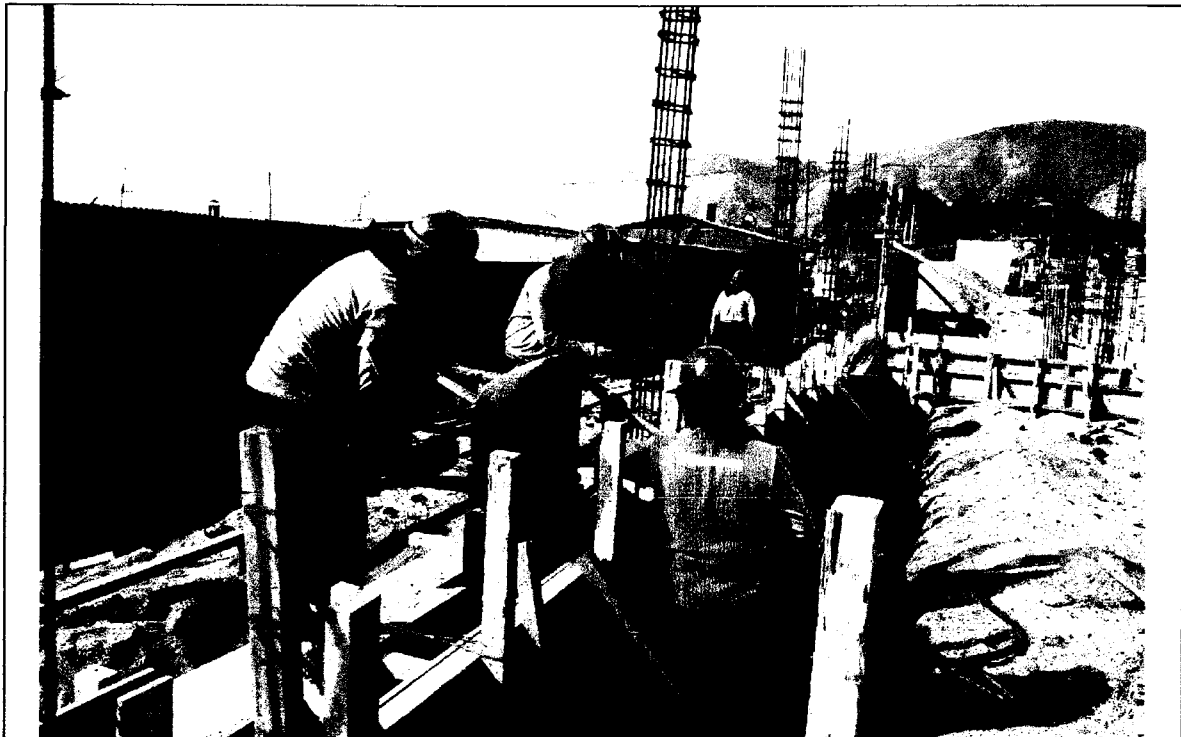
Foto N° 13: VACIADO DE CONCRETO F'c=210 kg/cm2 , EN VIGA DE CIMENTACION DEL MODULO II.
