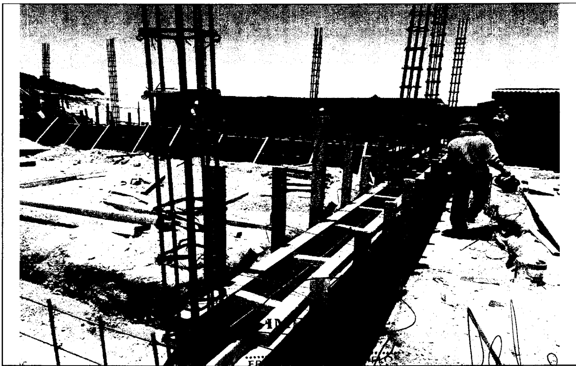
Foto N° 12: ENCOFRADO DE VIGAS DE CIMENTACION Y SOBRECIMIENTOS DEL MODULO II.
